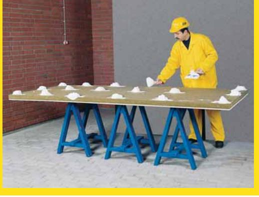
*Kalibel levha kaldırılarak duvar dibinde, döşeme üzerine önceden yerleştirilen 10 mm.'lik ahşap kamalar üzerine oturtulur.*
